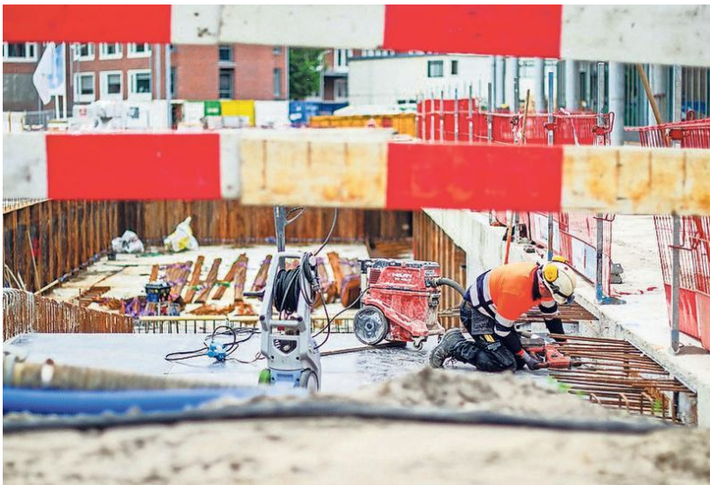
De helling van de parkeergarage wordt binnenkort gestort.
